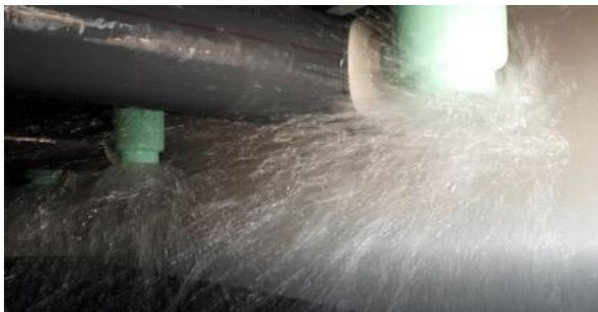
Gut aufbereitetes Wasser verhindert Ablagerungen und Kalkablagerungen im Kühlturm, die in der Regel in der Anlage zu finden sind. Es hat auch einen großen positiven Einfluss auf die Minimierung der möglichen Vermehrung und Verbreitung von organischen Stoffen (Algen) oder Bakterien, einschließlich der am weitesten verbreiteten und potenziell gefährlichen Bakterien, die Legionellose, verursachen können.
