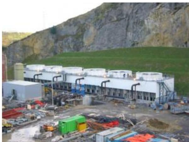
Modulare Kühltürme können aus Metall oder anderen Materialien hergestellt werden, die weniger „empfindlich“ auf das Vorhandensein von Wasser und dessen mögliche korrosive Wirkung reagieren, wie z. B. Glasfaser. Zellenkühltürme werden aus einer Metallstruktur oder aus stranggepressten Glasfaser- oder sogar Betonprofilen gebaut (klassische hyperbolische Türme von Kernkraftwerken).
