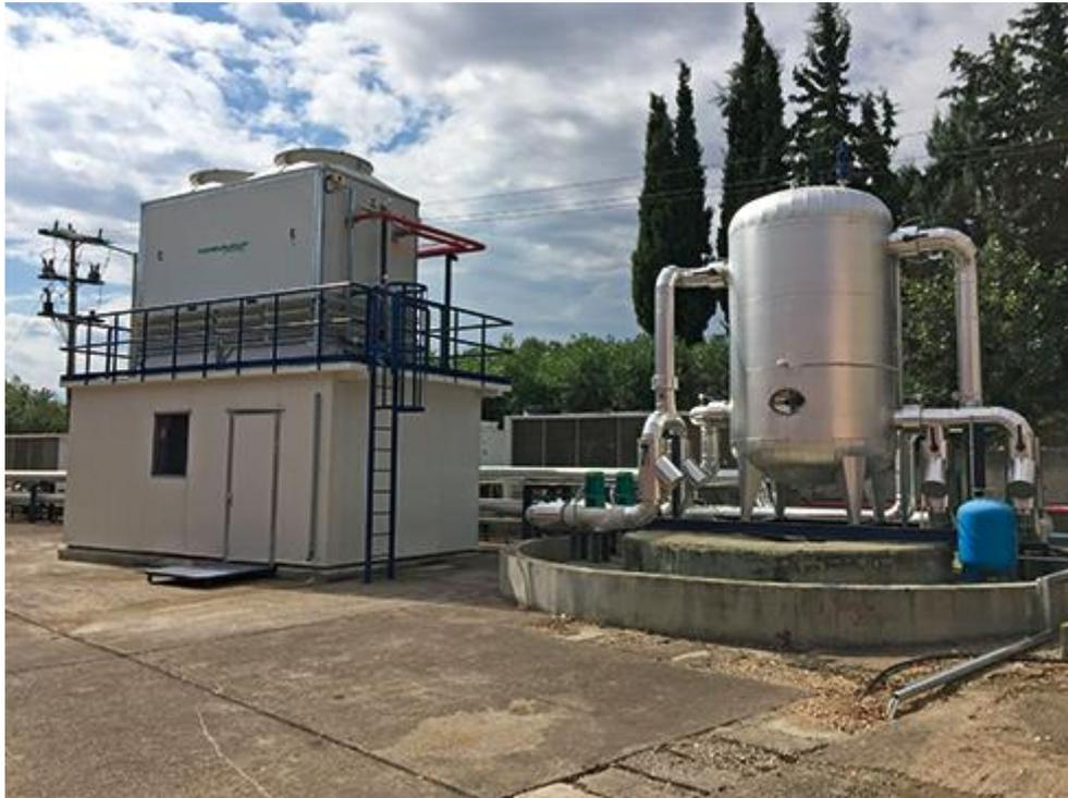
Trockenkühler beruhen auf dem Austausch von fühlbarer Wärme. Der Grenzwert wird in diesem Fall durch die Temperatur der Kühlflüssigkeit, d.h. der Umgebungsluft, festgelegt. Bei dieser Art der Kühlung können Mindesttemperaturen von etwa 5 °C über der Umgebungstemperatur erreicht werden.
