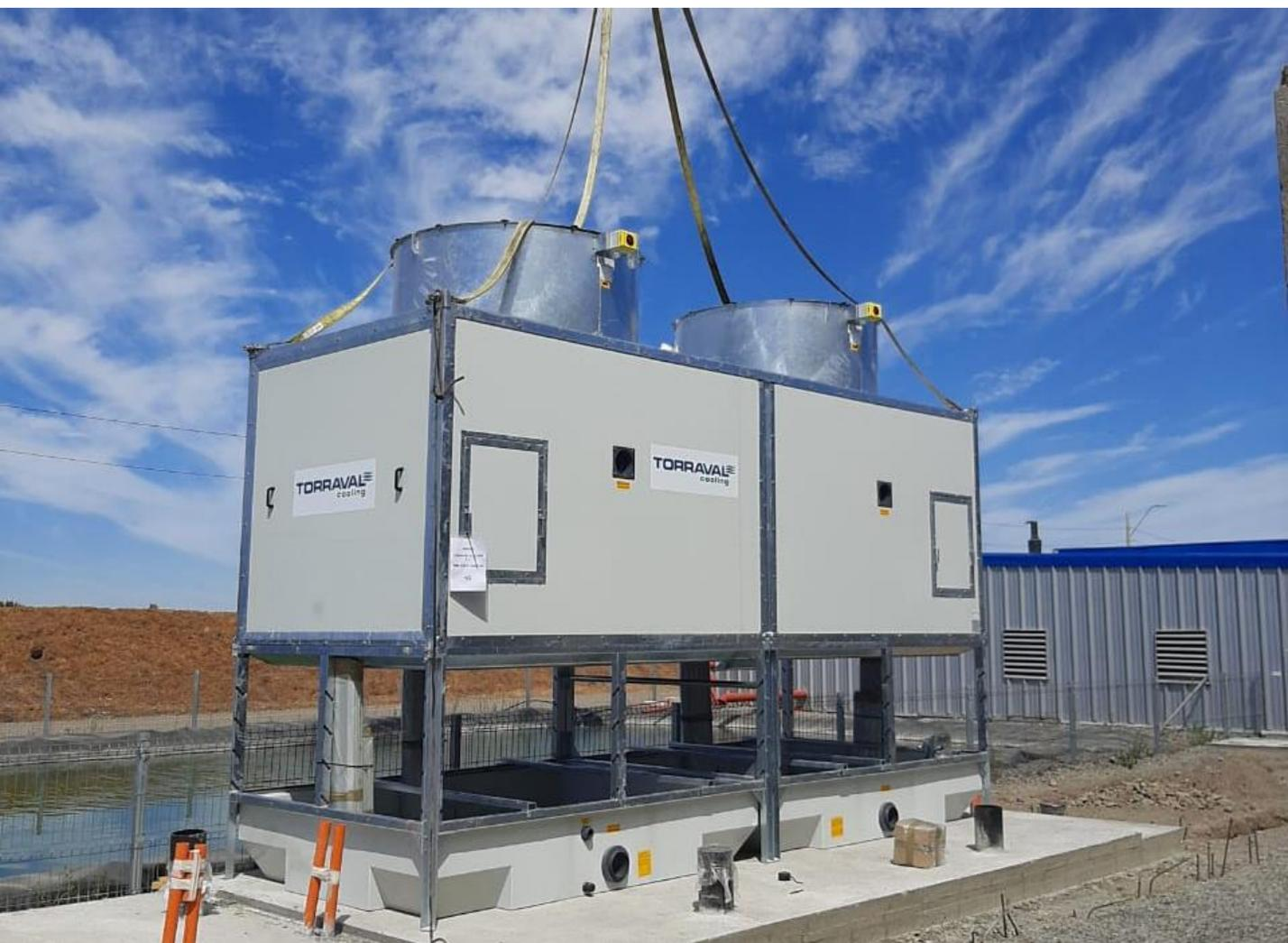
[Ingeniería Ingal](#), encargada del proyecto, decide instalar un sistema de enfriamiento auxiliar anexo al existente en base a torres de refrigeración evaporativas con intercambiadores de calor incorporado al circuito de enfriamiento existente.
