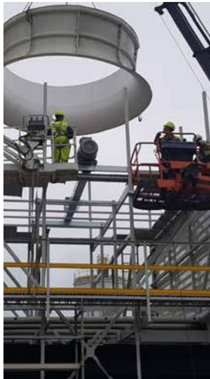
EJECUCIÓN DEL PROYECTO DE INSTALACIÓN
