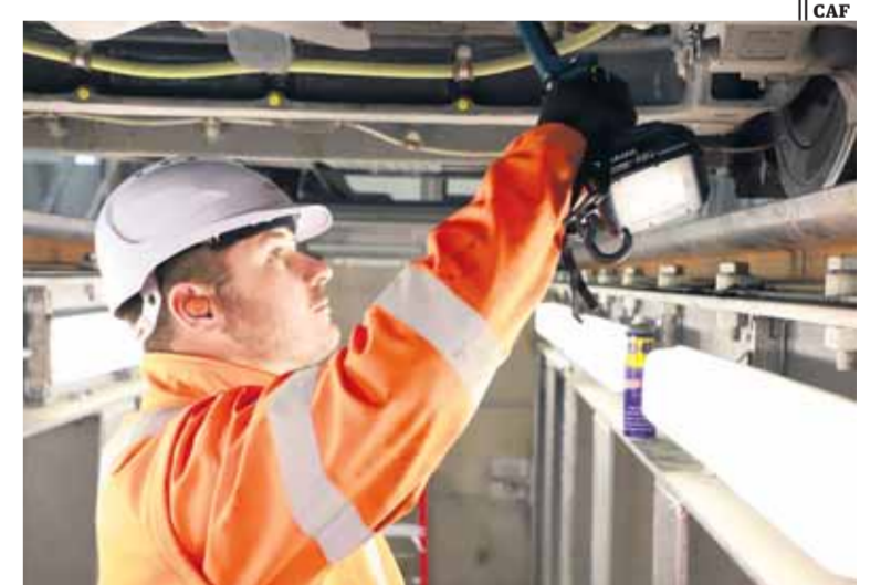
Operación de mantenimiento por parte de CAF
