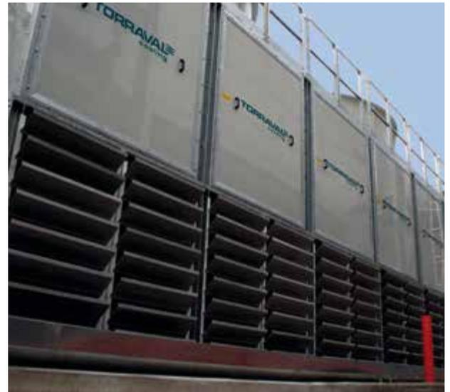
Todas las torres de refrigeración serie PMM están equipadas con diferentes tipos de rellenos seleccionados en función del tipo de agua a refrigerar y de las necesidades del cliente.
